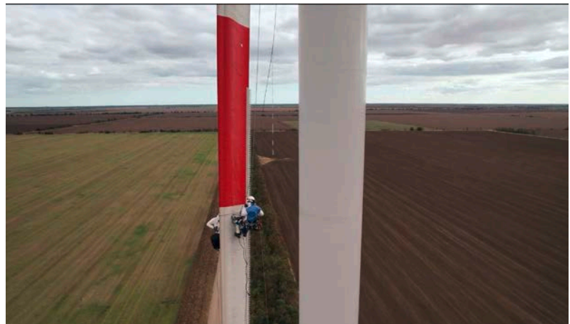
Rotorblattspektion durch TÜV Süd
