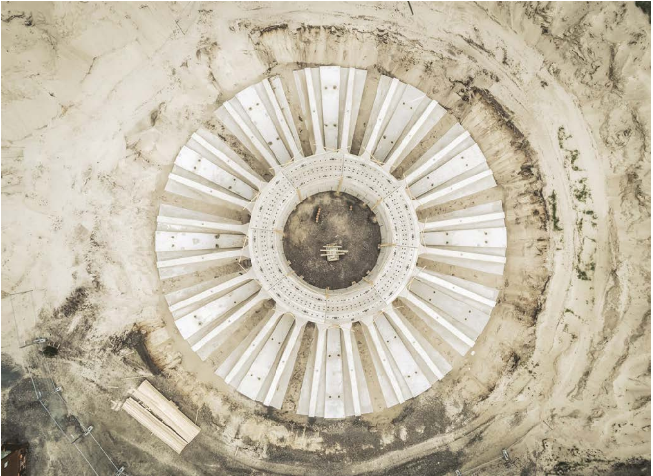
Aufgelöstes Fundament im Betonfertigbau von Anker Foundations: Gut zu sehen sind Lastverteilplatten zwischen den Rippen zur Beschwerung mit Erde.
