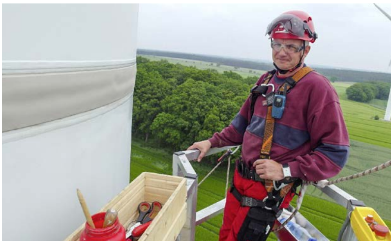
Torsten Laderholz, KTW Umweltschutztechnik, bei Sanierungsarbeit an einem Hybridturm
