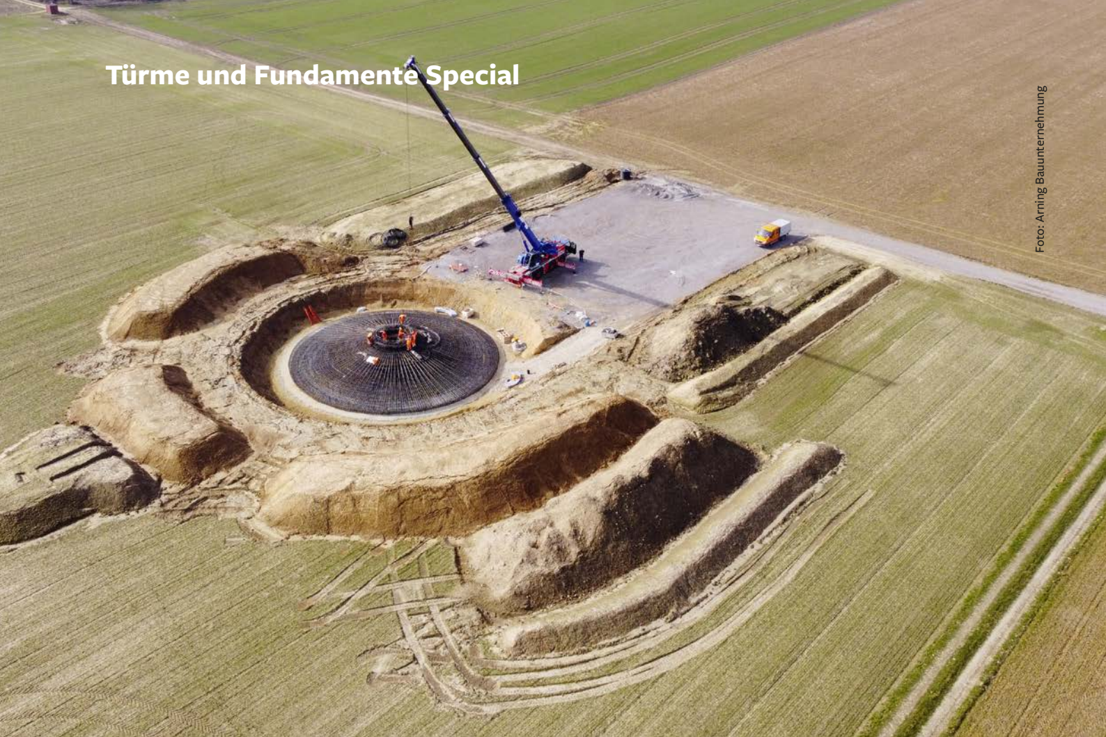
Mustergültig angelegter Großfundamentbau von Arning Bauunternehmung für eine moderne Windenergieanlage
